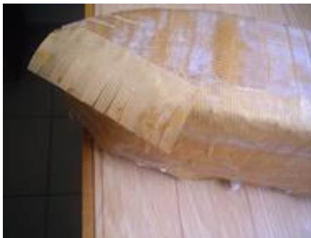
découpe sur place pour les longues courbes, puis pliage en lissant
